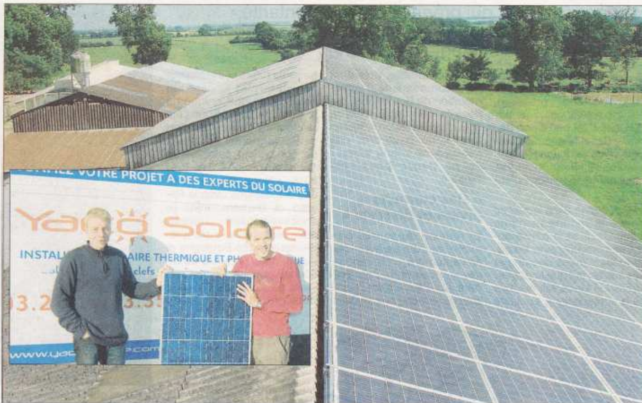
Dans le canton de Desvres, les deux frères ont installé 500 m 2 de panneaux photovoltaïques. Un record sur la Côte d'Opale.
